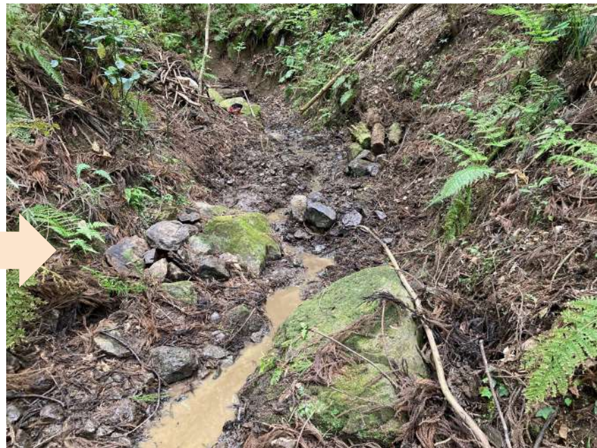
堆積物を除いて水の通り道を作った
